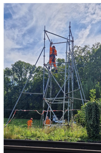
Abbruch des Bauvisiers für die Mobilfunkanlage in Kreuzlingen (Foto: Heike Manz-Salzmann)
