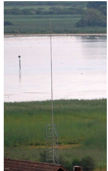
Bauvisier der Mobilfunkanlage beim Bahnhof in Triboltingen (Foto: SFK)
